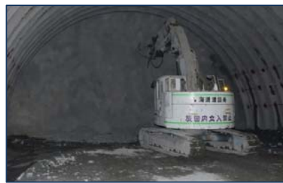
掘削機によるトンネル切り羽(掘削面)での作業を見学
