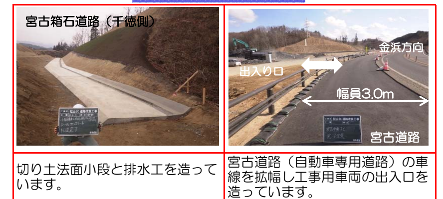
②施工：松尾建設
