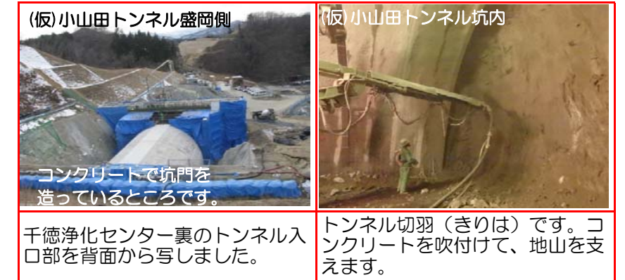
①施工：前田建設工業
